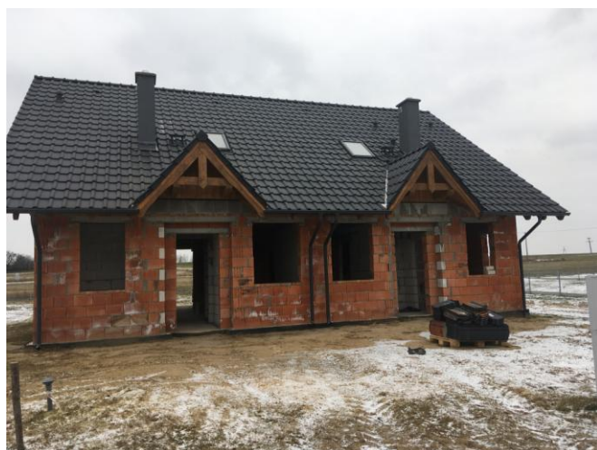
Nowopowstający dwulokalowy budynek mieszkalny w obrębie planu
